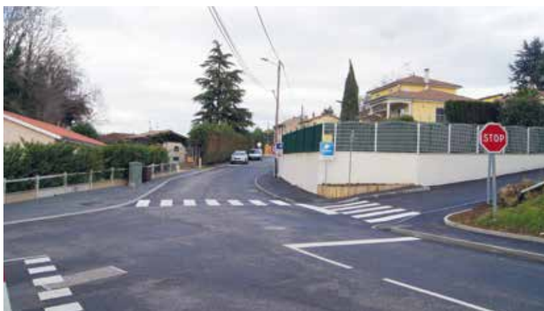
Carrefour route de Genay/Chemin du Fagot/Chemin des Varennes Réalisation de trottoirs, chicane, nouvelle signalisation
